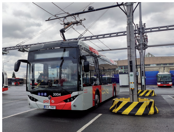
Dobíjecí základna parciálních trolejbusů v garážích Klíčov
