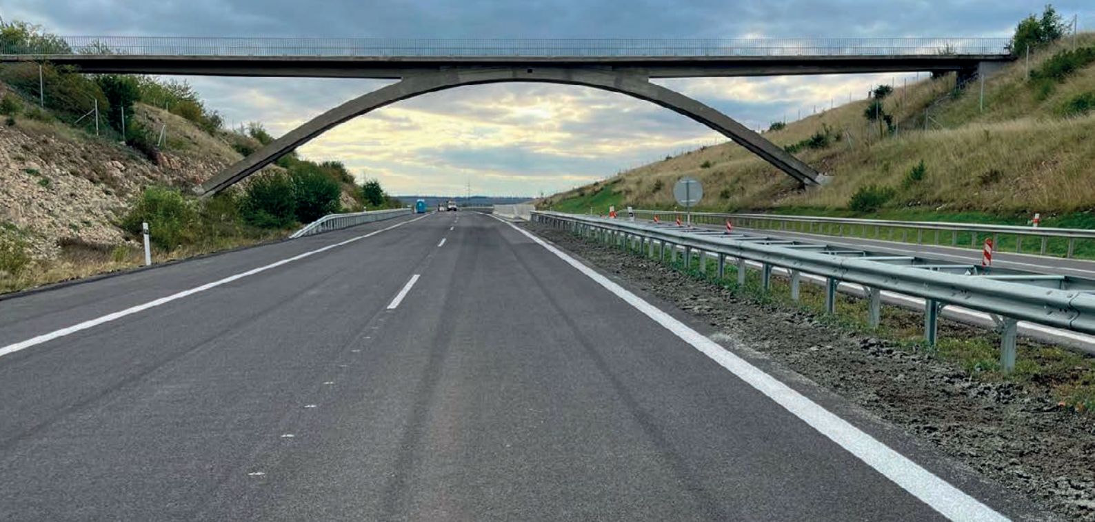
Po dokončení realizace stavby (před spuštěním provozu).
