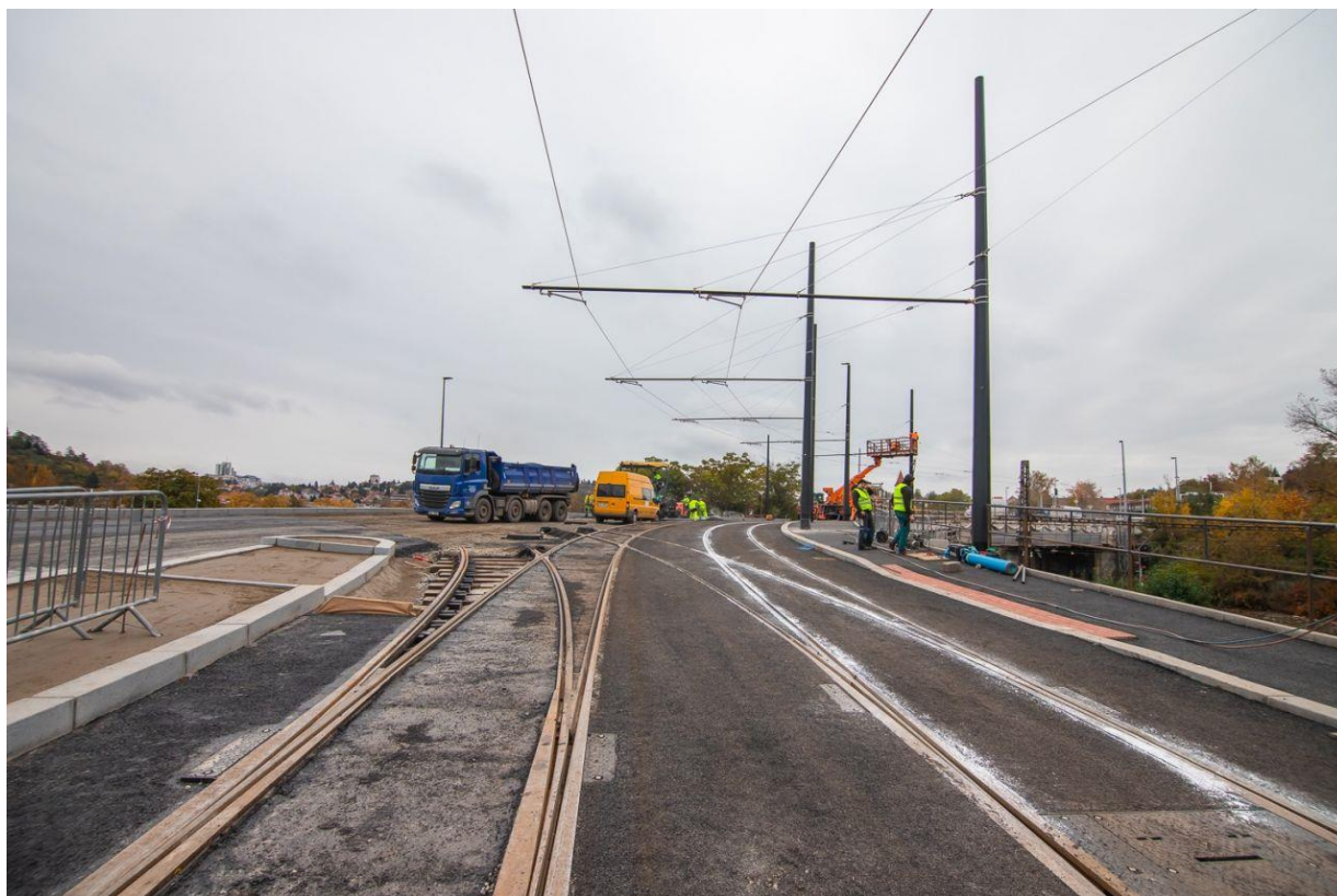
Obr. 2 - rekonstrukce tramvajové tratě v Nádrazní ulici s kolejovým rozvětvením na (tehdy připravovaný) Dvorecký most, 2020 (prazsky.denik.cz)
